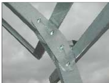
Liaison berceau-rehausse renforcée. 2 positions modifiables par boulonnage
